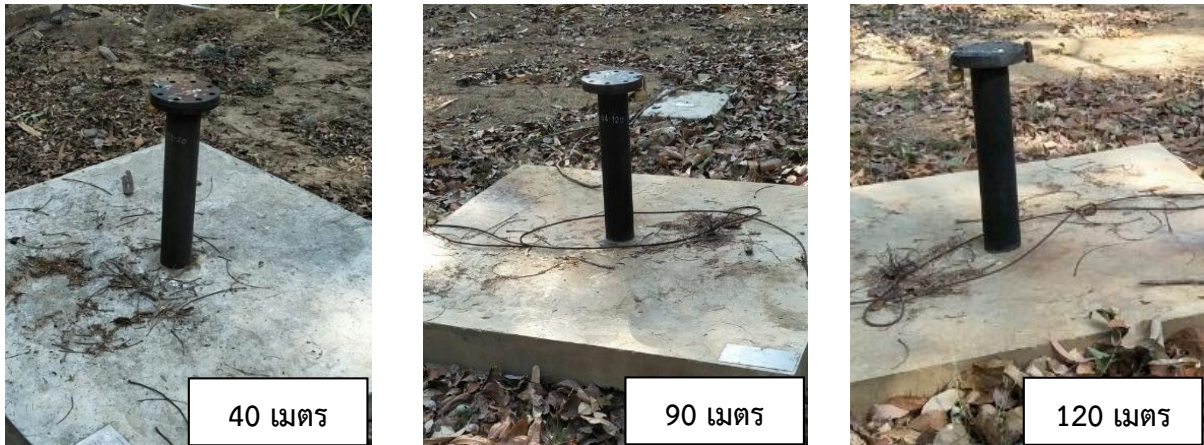
รูปที่ 4.16 การตรวจวัดระดับน้ำและเก็บตัวอย่างน้ำใต้ดินบ่อ ST04 ระดับความลึก 40, 90 และ 120 เมตร
